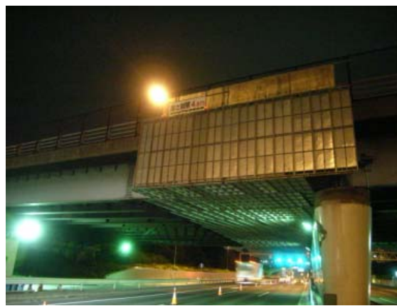
仮設吊り足場
