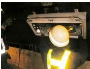
トンネル照明設備清掃・点検
