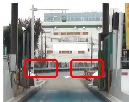
ETCレーン発進制御バー開放(実験中)
