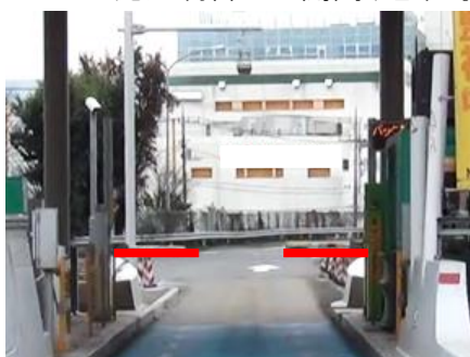
ETCレーン発進制御バー開閉(通常時)
