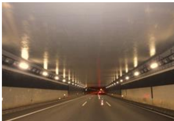
はく落対策工事(完成写真)
