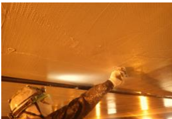
はく落対策工事(作業写真)
