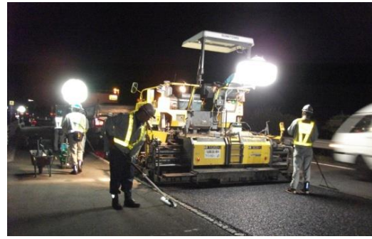
夜間舗設作業状況
