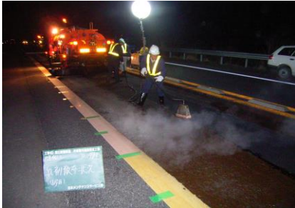
舗装補修工事
